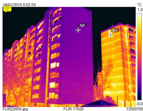
Figura 8. Termografía: Después de obra.
