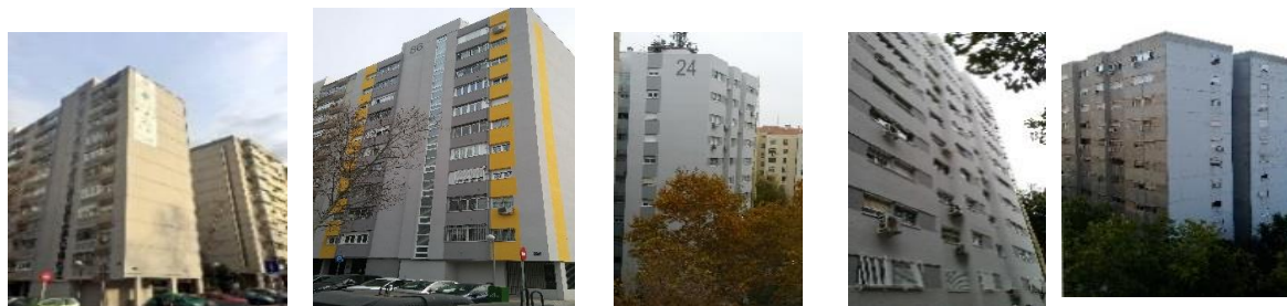
Figura 11: Bloque y torre, antes y después obra
