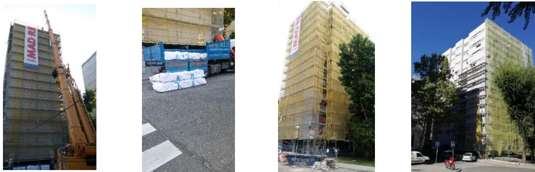
Figura 10. Desamiantado y obras
