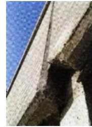
Figura 5. Desprendimiento paneles de fachada.
