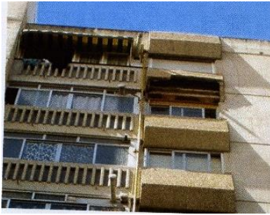
Figura 3. Desprendimiento antepecho.
